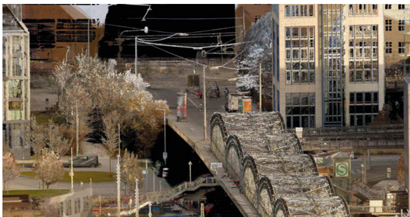
03 Actemium setzt den Navis VLX 3 auch ein, um digitale Zwillinge von weitläufigen Baustellenarealen selbst im Fernbereich mit hohem Detailgrad zu realisieren.
