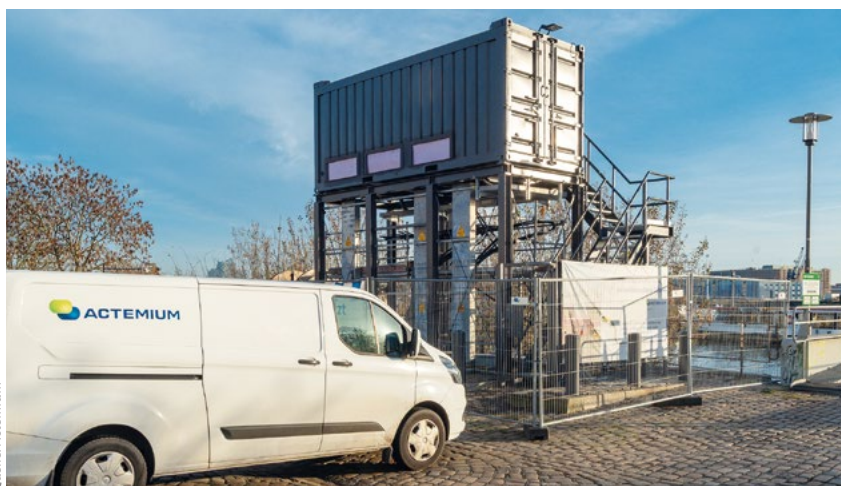
Der 20-Fuß-Übergabecontainer für eine Leistung von 8 MVA steht an der Hafenkante. Eine Unterkonstruktion von Aug.Prien schützt ihn vor der Flut.
